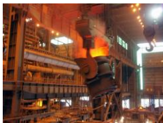
Pont roulant d'aciérie Arcelor Mittal Belval 2008
